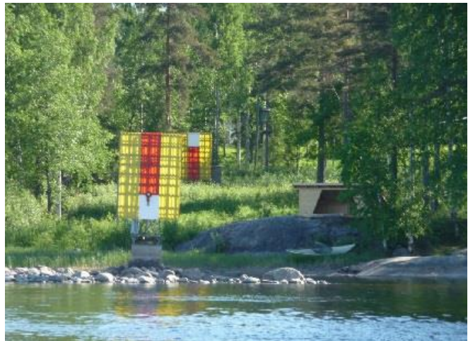
Kuvat 2 ja 3: Kartta turvalaitteiden tarvitsemasta maa-alasta ja syväväylän linjamerkin taulut järveltä katsottuna (kuvalähde Meritaito Oy)
