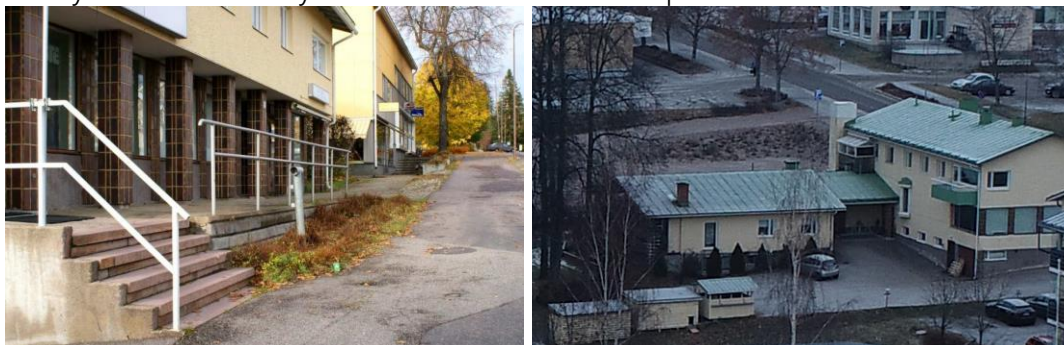
Kuva Vasemmalla Säästöpankin talon julkisivun klinkkeripintaa (Kuva: Teija Ahola). Oikealla viistokuvista (MMPalvelu Puttonen 2022) tallennettu leike takajulkisivusta.
