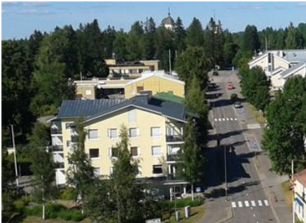
Kuva: Kesäisessä kuvassa on vuonna 2004 valmistunut kerrostalo eli tontti numero 3.
